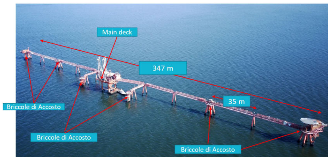
Figura 3.1: Struttura della Piattaforma Petra Esistente
